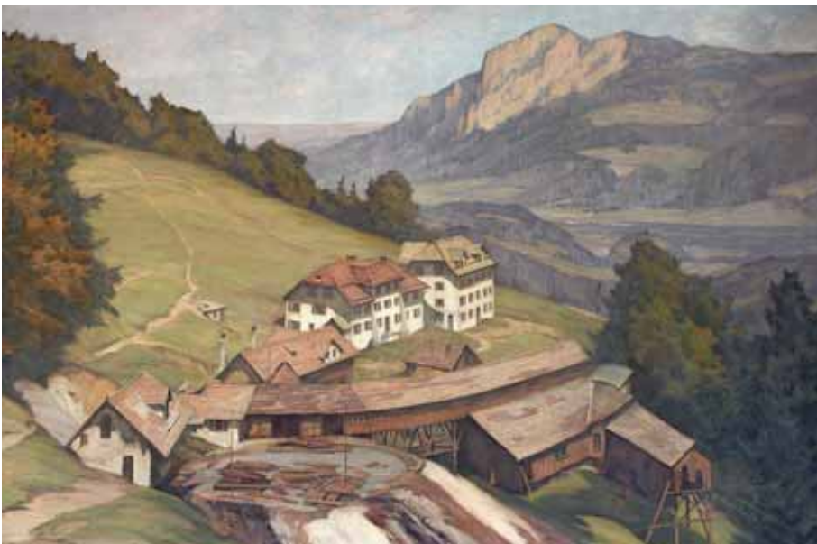
Die Anlage Naus bestand aus Knappen- und Maschinenhaus. Im Maschinenhaus waren drei Rotationskompressoren für 40 Bohrhämmer, die Ventilations- und Transformeranlage. (EGAG)
