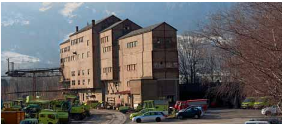
In der Anlage Malerva Sargans wurde das Erz zerkleinert, sortiert und in Bahnwagen verladen. (Bild B. Moser, 2018)
